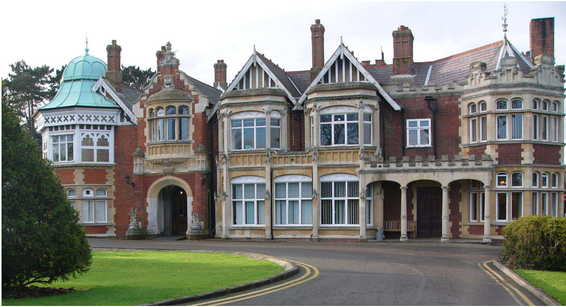
Figura 24. Fachada principal de Bletchley Park en la actualidad. 26
