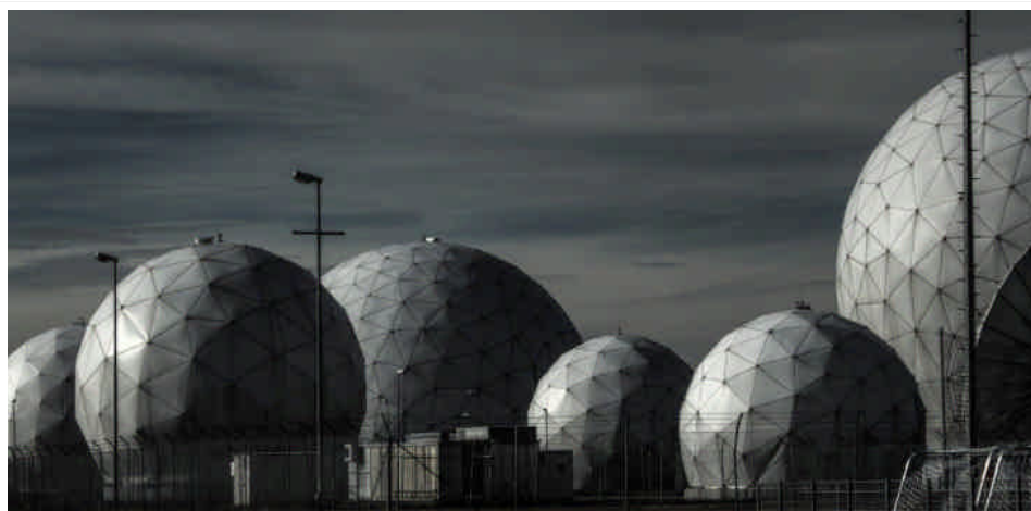
Rechtsfreier Raum? Radome in der BND-Außenstelle Bad Aibling.
