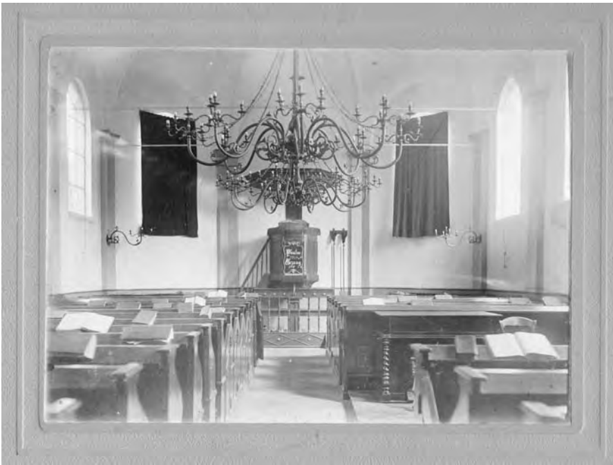
VII. Helenaveen. Nederlands hervormde Kirche. Nach der Einweihung der Kirche 1867 bekam Helenaveen einen eigenen Pfarrer, dominee Swalve jr. Grashof nutzte die Kirche ab 1872. Äußeres und Inneres. Fotos 1875. Regionaal Historisch Centrum Eindhoven, Archief NV Maatschappij Helenaveen.
