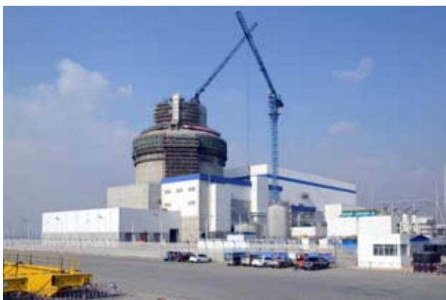
图 17 海阳核电厂 1 号机组
