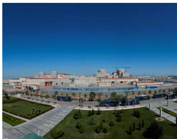
图 4 红沿河核电厂一期工程 4 台机组全景图
