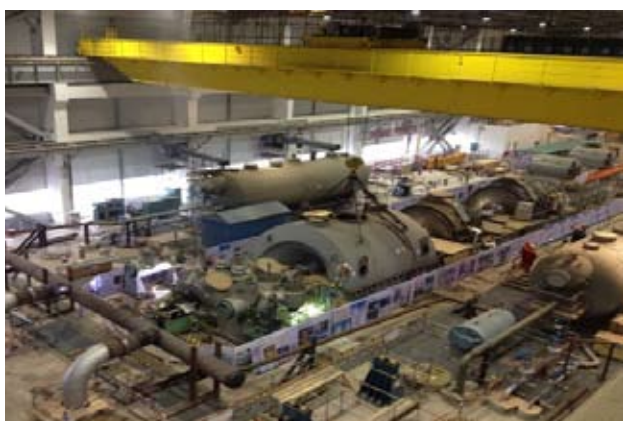
图 20 海南昌江核电厂 1 号机组汽轮机开始扣缸
