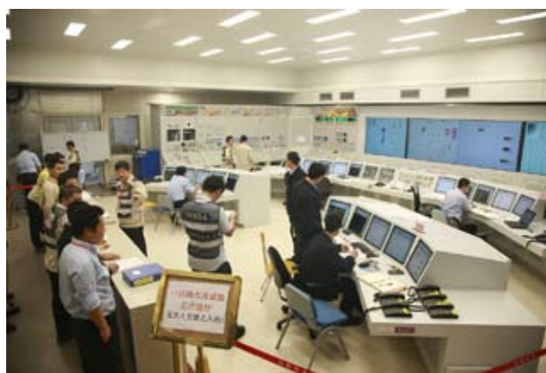
图 21 海南昌江核电厂 1 号机组一回路水压试验监督
