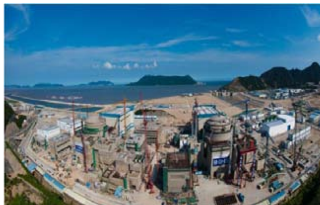
图 19 台山核电厂全景
