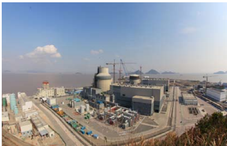
图 15 三门核电厂主厂址全景
