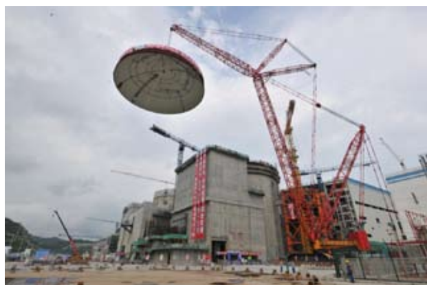
图 12 阳江核电厂 4 号机组穹顶吊装
