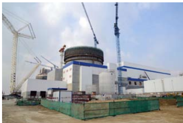
图 18 海阳核电厂 2 号机组
