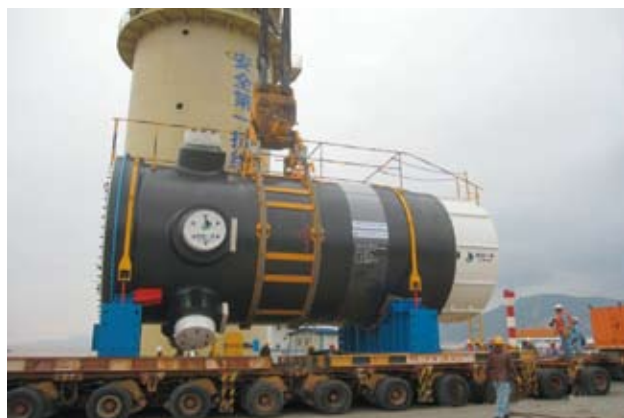
图8 宁德核电厂4号机组核岛反应堆压力容器到货
