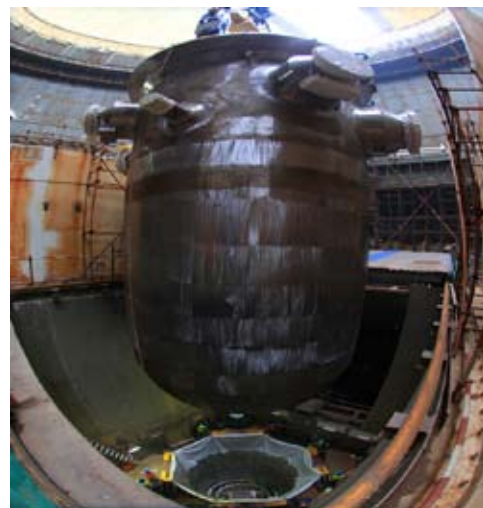
图 16 三门核电厂 2 号机组压力容器吊装完成
