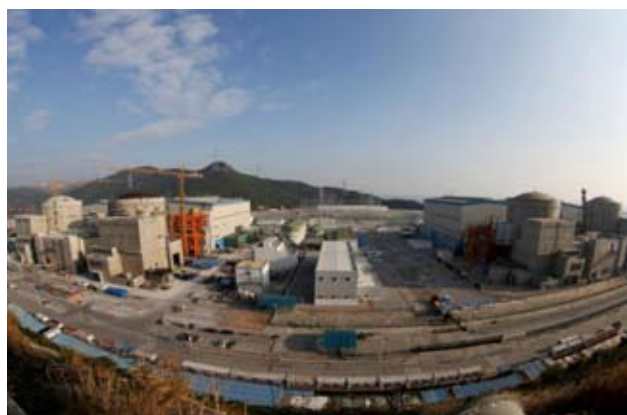
图 11 阳江核电厂 1 ~ 6 号机组全景
