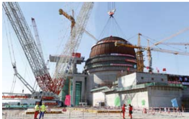
图 24 田湾核电厂 3 号机组核岛安全壳穹顶吊装
