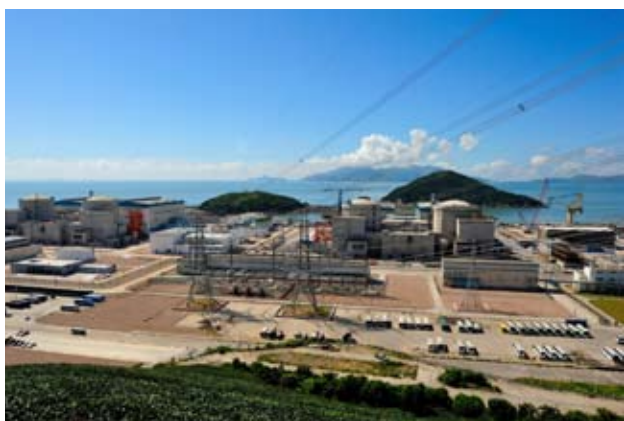
图 5 宁德核电厂 1 ~ 4 号机组全景
