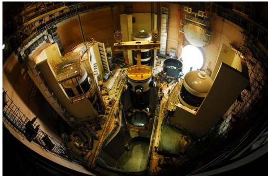
2012年2月17日，2号机组压力容器吊装就位
