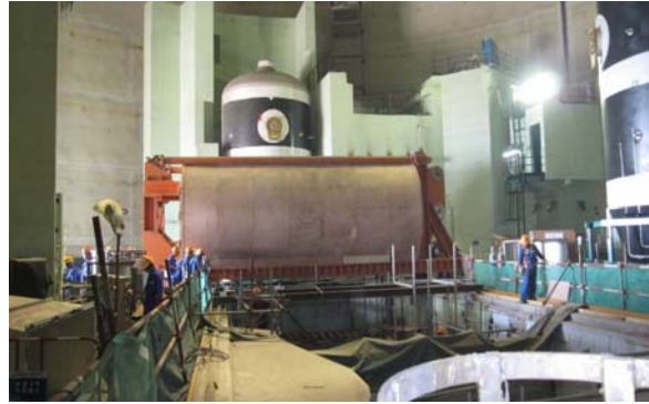
福清核电站1号机组核岛内部
