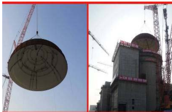
2012年5月5日，4号机组穹顶吊装成功
