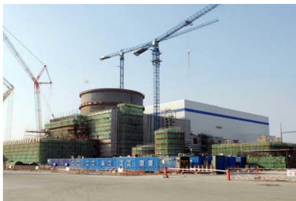
海阳核电厂1号机组全貌
