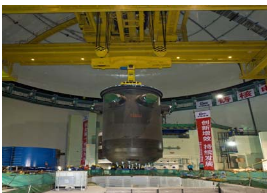
2012年4月30日，1号机组压力容器引入就位
