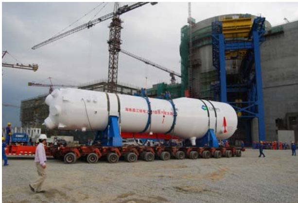
2012年11月13日，1号机组1B蒸汽发生器引入核岛
