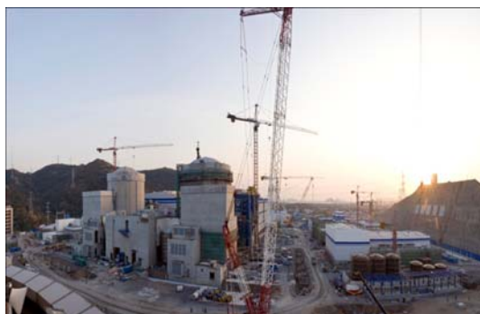
秦山核电厂扩建项目1、2号机组
