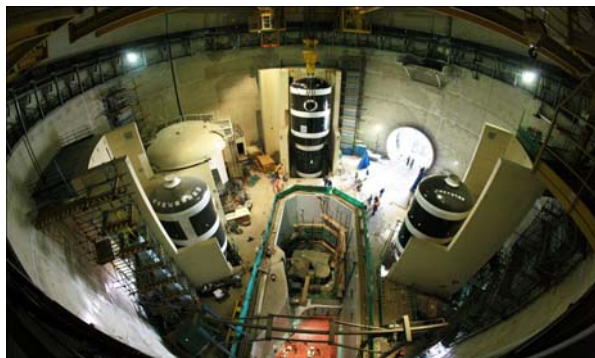
2012年11月5日，2号核岛3号蒸汽发生器就位
