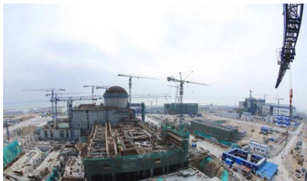
福清核电厂1~4号机组（2012年10月9日，3号核岛穹顶吊装）
