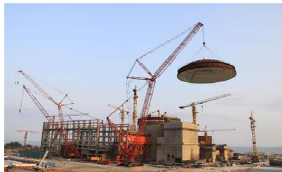
2012年4月13日，1号机组穹顶吊装就位
