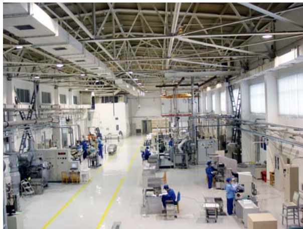
202厂重水堆元件厂组装车间
