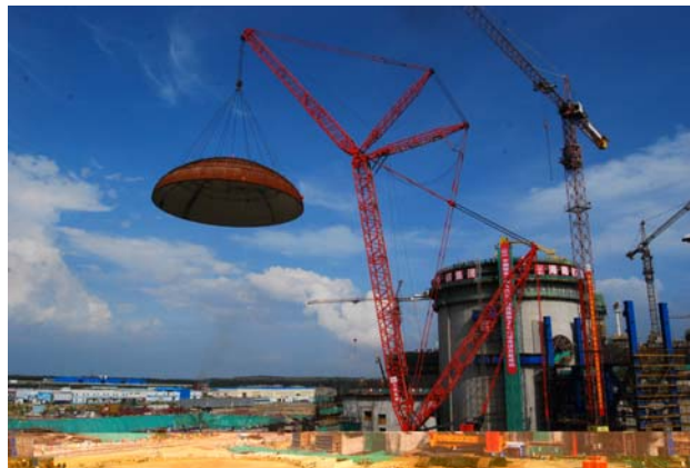
2012年9月25日，2号机组核岛吊装穹顶
