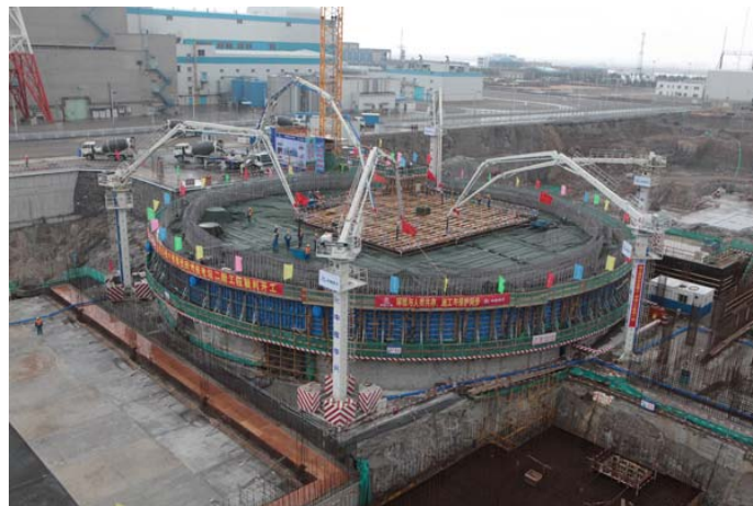
田湾核电站3号机组核岛浇灌第一罐混凝土
