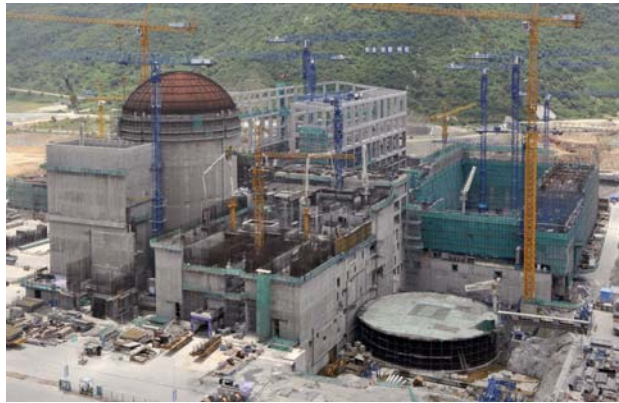
阳江核电站3、4号机组（2012年6月9日，3号核岛穹顶吊装）
