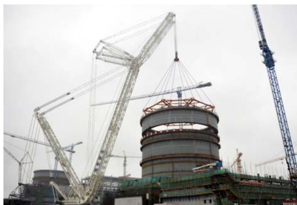
海阳核电厂2号钢制安全壳筒体四环吊装就位
