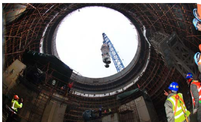
三门核电厂1号机组蒸汽发生器1A吊装就位
