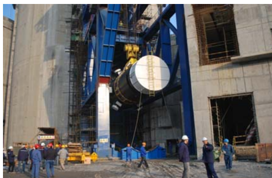
2012年12月13日，2号机组压力容器引入就位
