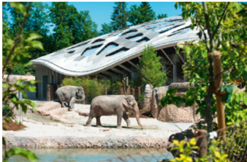
Der Betonring des Elefantenparks im Zoo Zürich wird durch Dehnungssensoren überwacht.
