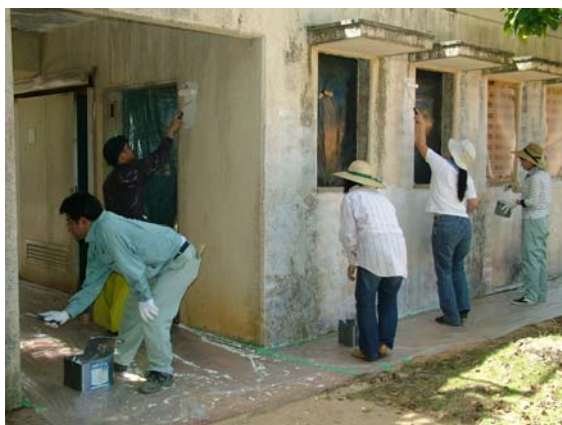
公園ボランティア協定による漫湖公園のトイレの落書き落としと塗装作業
