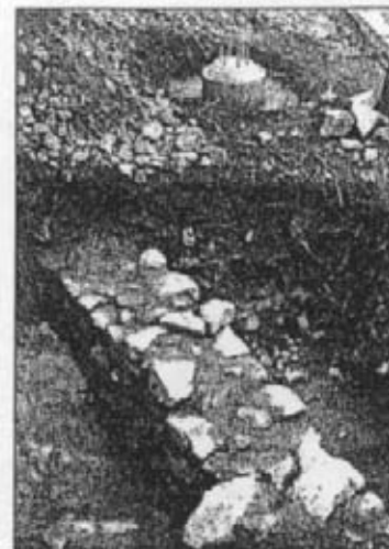
Τοποθέτηση τοιμεντένιων και βάσεων για τα κάγκελα πάνω σε αρχαιολογικά ευρήματα
