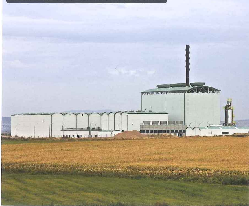
Planta de biomasa por combustión de biomasa mixta de ACCIONA en Miajadas
