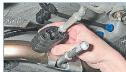
...и надеваем подушку сначала на кронштейн кузова и затем на кронштейн трубы.
