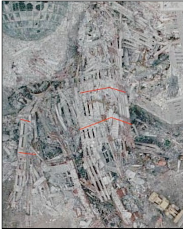
Fig. A-2 -- Tower 1 West face debris
