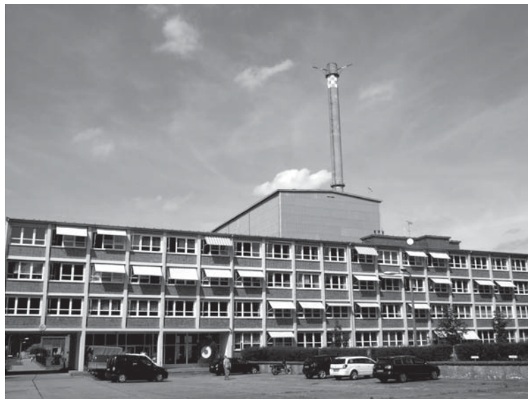
In dem Anbau hinter dem Verwaltungsgebäude befand sich der Reaktor
