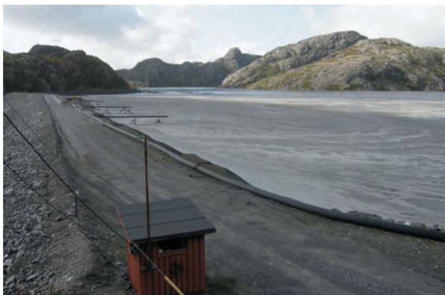
Eksempel på tailingsdeponi i forbindelse med Titania minen i Syd norge. Dæmningen bygges højere i takt med at tailingsniveauet stiger.
