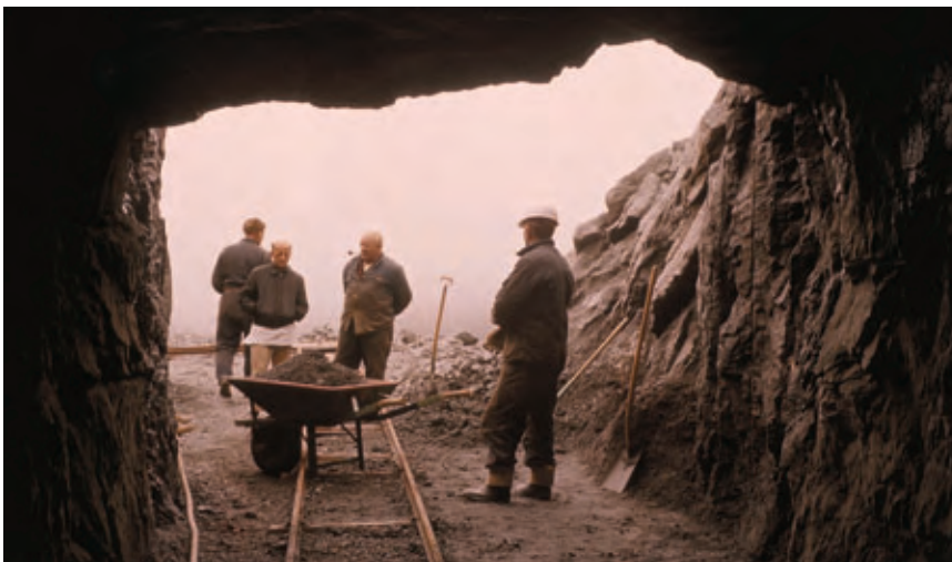
Ved den første prøvebrydning på Kvanefjeld 1958 blev der etableret en tunnel på 50 m, således at uforvitret malm kunne brydes.
