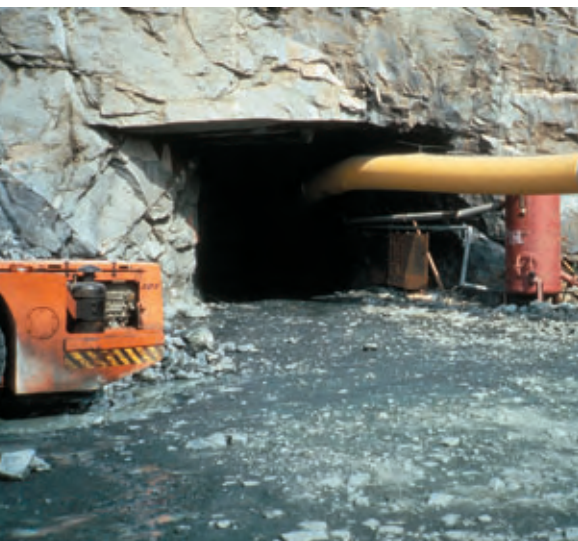
Ved fornyede undersøgelser på Kvanefjeld 1978 blev der sprængt en 960 m lang tunnel, hvorfra 20 000 ton malm blev hentet. Det kraftige udsugningsanlæg, som sikrer at radonmængden ledes væk fra minen, ses som et gult rør.
