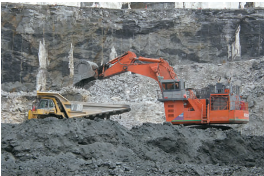
Opsamling af materiale efter sprængning i en åben mine. Herfra transporteres overjord og ikke-værdifulde bjergarter til deponering og malmen til knusning.
