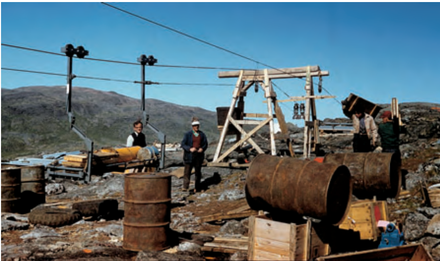
Det var nødvendigt at etablere en tovbane til transport af boreudstyr. Boreprogrammet skulle undersøge indholdet af uran i Kvanefjeld i 1958.
