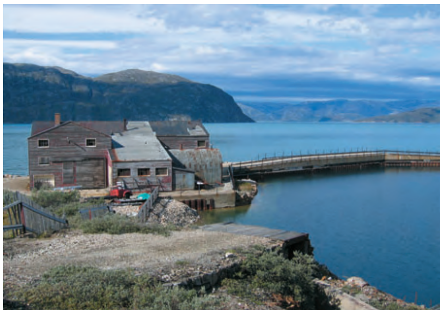
Kryolitbruddet ved Ivittuut i Sydvestgrønland, 2010. Bruddet var oprindeligt afskærmet mod fjorden af en dæmning og holdtes tørt ved en konstant udpumpning af indsivende vand. Efter lukningen i 1987, trængte vandet gradvist ind, og hullet er nu helt vandfyldt.
