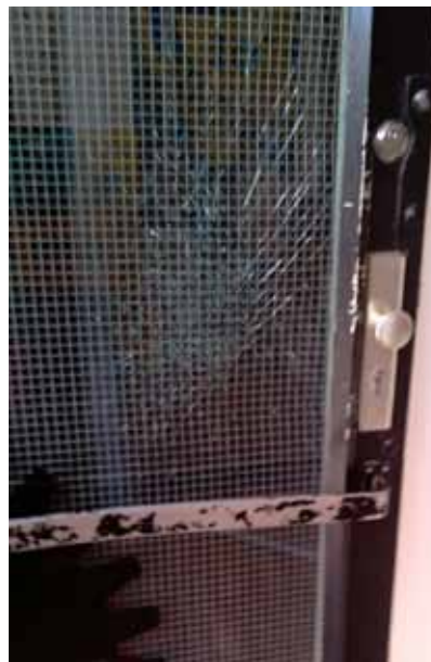
Beschädigte Eingangstür am Gruppentreffpunkt der Ultras Braunschweig. (Foto: privat)
