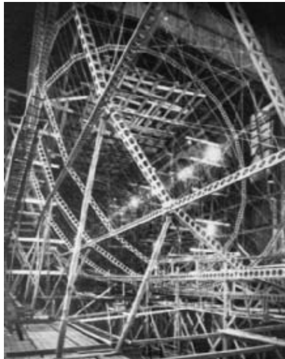
Fig. 62: Airframe of SL-2. (Schütte)
