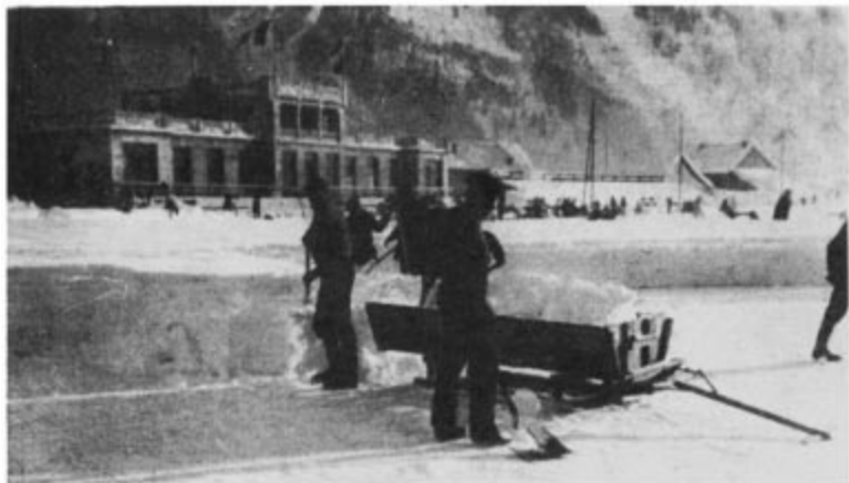
Une rafale de neige s'abattit sur Chamonix quelques jours avant l'ouverture des Jeux d'Hiver. Les travaux de déblaiement de la patinoire.
