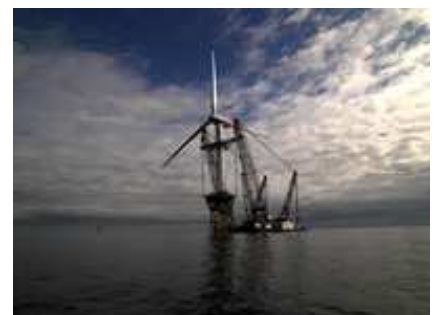
Obrázok 10.8. Stavba Beatrice, ukážka veternej elektrárne v hlbokých moriach. Fotografie poskytla Talisman Energy (UK) Limited.
