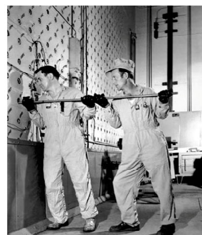
Obrázok 24.3. Pracovníci zasúvajú uránové valce do grafitového reaktora X-10.
