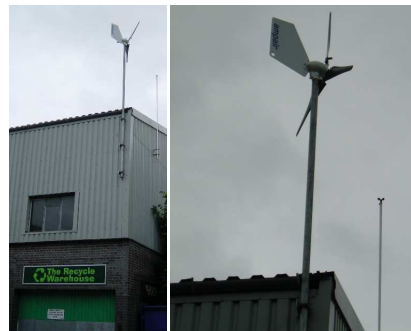
Obrázok B.9. „60 W“ mikroturbína Ampair. Priemerná energia vyrobená touto mikroturbínou v kúpeľoch v Leamingtone je 0,037 kWh za deň (1,5 W).
