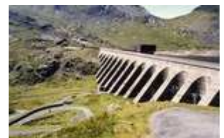
Obrázok 26.6. Llyn Stwlan, horná nádrž uskladňovacieho zariadenia Ffestiniog v severnom Wales. Uskladnená energia: 1,3 GWh. Fotografia: Adrian Pingstone.
