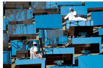
Obrázok 25.12. Dvaja inžinieri skladajúci koncentračnú slnečnú elektrárňu eSolar za použitia heliostatov (zrkadlá, ktoré sa otáčajú a nakláňajú za Slnkom). Esolar.com vyrába slnečné elektrárne strednej veľkosti: 33 MW (maximum) zariadenie na 64 hektároch. To je maximum 51 W/m 2 , takže by som povedal, že na typickej lokalite na púšti by vyrobili približne jednu štvrtinu tohto množstva: 13 W/m 2 .
