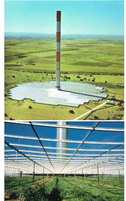
Obrázok 25.10. Prototyp komínovej elektrárne v Manzanares. Fotografie od solarmillennium.de.
