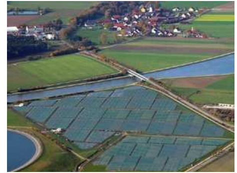
Obrázok 6.7. Slnečná fotovoltaická elektráreň: 6,3 MW (maximum) Solarpark v Mühlhausene, v Bavorsku. Predpokladaný priemerný výkon na plochu je 5 W/m 2 . Foto od SunPower.
