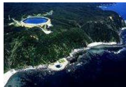
Obrázok 26.11. Zariadenie PVE, ktorého nižšiu nádrž tvorí oceán. Uložená energia: 0,2 GWh. Fotografia J-Power. www.ieahydro.org .
