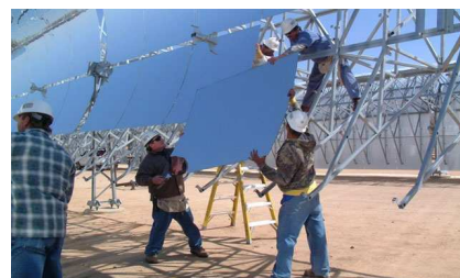
Obrázok 25.4. Andasol – rozostavaná „100 MW“ slnečná elektrárň v Španielsku. Nadbytočná tepelná energia vyrobená cez deň sa uloží v nádržiach s tekutou soľou až na sedem hodín, zabezpečujúc tak sieť nepretržitým a stabilným zásobovaním elektrickým výkonom. Elektrárň by mala podľa predpokladov vyrábať 350 GWh za rok (40 MW). Parabolické oblúky zaberajú 400 hektárov, takže výkon na jednotku plochy krajiny bude 10 \text{ W/m}^2 .
