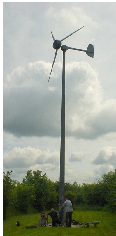
Obrázok B.10. 5 kW turbína s priemerom 5,5 m s názvom Iskra [www.iskrawind.com] pri ročnej revízii. Táto turbína umiestnená v Hertfordshire (nie tá z najveternejších lokalít v Británii) s výškou 12 m priemerne vyrobí 11 kWh za deň. Veterná elektráreň s turbínami s takouto výrobou s plochou 30 m × 30 m by mala hustotu výkonu 0,5 W/m 2 .
