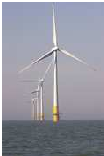
Obrázok 10.1. Kentish Flats – morská veterná elektrárň v plytkom mori. Každý rotor má priemer 90 m so stredom vo výške 70 m. Každá „3MW“ turbína má hmotnosť 500 ton, pričom polovica z nej je v základoch. Fotografie © Elsam (elsam.com). Použité s povolením.
