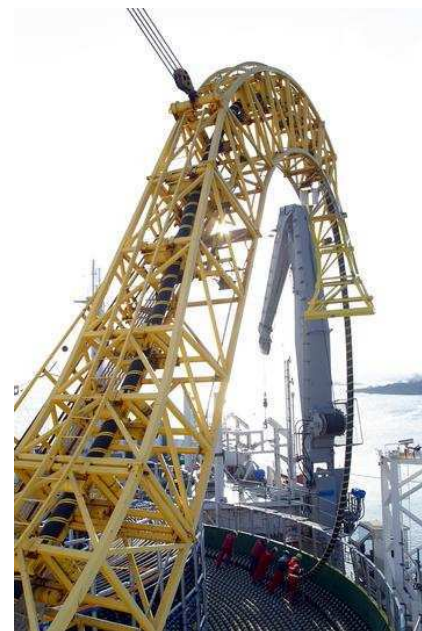
Obrázok 25.7. Pokladanie vysoko napäťového DC spojenia medzi Fínskom a Estónskom. Dvojica týchto káblov prenáša výkon 350 MW. Fotografia: ABB.
