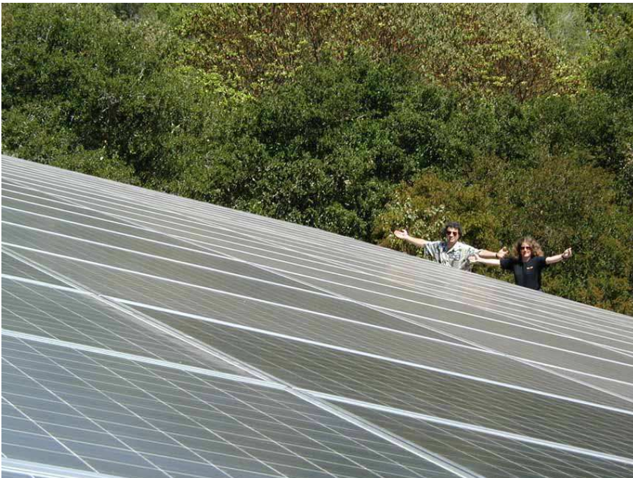
Obrázok 6.6. Dvaja solárni bojovníci sa tešia zo svojho fotovoltaického systému, ktorý nabíja ich elektrické autá a dom. Súbor 120 panelov (každý 300 W a 2,2 \text{ m}^2 ) má plochu 268 \text{ m}^2 , maximálny výkon (po započítaní strát pri premene z jednosmerného na striedavý prúd (DC na AC)) je 30,5 kWh, a priemerný výkon – v Kalifornii, blízko Santa Cruz – je 5 kW ( 19 \text{ W/m}^2 ). Fotografiu poskytol Kenneth Adelman. www.solarwarrior.com
