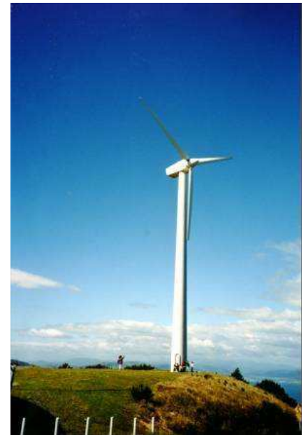
Obrázok B.3. Brooklynova veterná turbína nad Wellingtonom, Nový Zéland, s ľuďmi stojacimi pri základni. Počas veterného dňa táto veterná turbína produkovala 60 kW (1400 kWh za deň). Fotografia Philip Banks.
