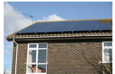
Obrázok 6.5. Slnečná fotovoltaika: hodnoty z 25 \text{ m}^2 plochy v Cambrigheshire v roku 2006. Maximálny výkon je 4 kW. Celoročný priemer je 12 kWh za deň. To je 20 W na meter štvorcový panelu.
