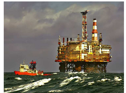
Obrázok 10.4. Plošina Magnus v severnom britskom sektore obsahuje 71 000 ton ocele. V roku 2000 táto plošina vyťažila 3,8 milióna ton ropy a plynu – výkon 5 GW. Stála 1,1 miliardy libier.
