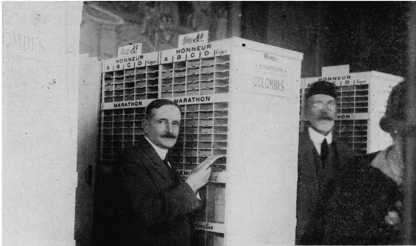
Meubles fabriqués spécialement pour recevoir les tickets d'entrée par réunion et par Stade. Celui-ci contenait les tickets des réunions n° 43 et 44 au Stade de Colombes (6.000 tickets par réunion)
