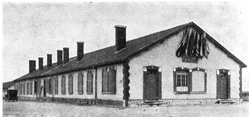
Le bâtiment des vestiaires.
