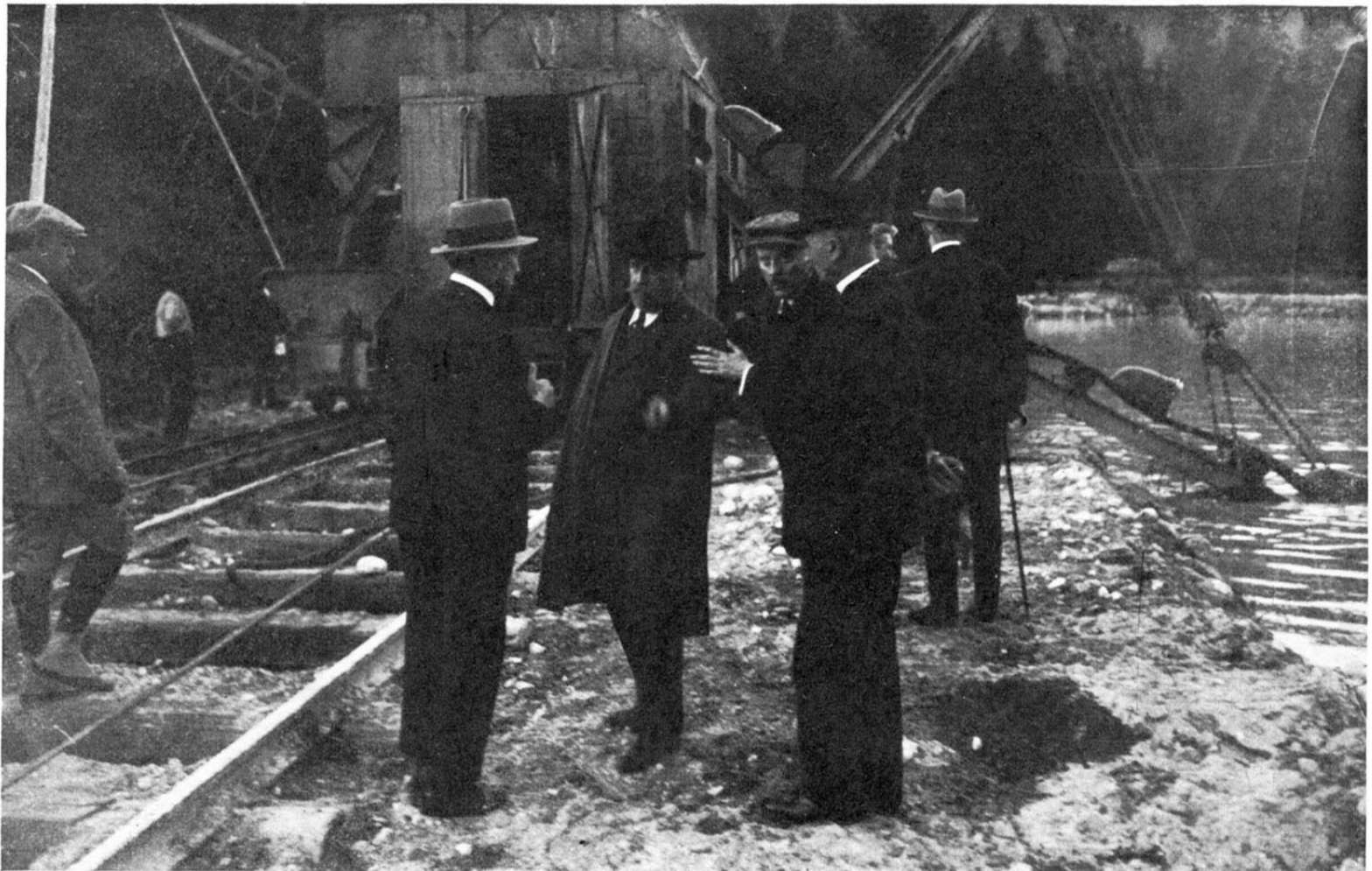
L'excavateur installé en bordure de l'Étang, dans le bois du Bouchet où furent prélevés les remblais de la patinoire. Au premier plan, de gauche à droite: MM. Baticle, Gilbert, Peycelon et J. Lavaivre.
