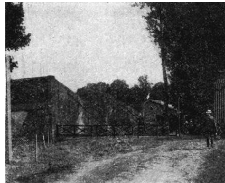
Les parabolles et murs de flancs.
